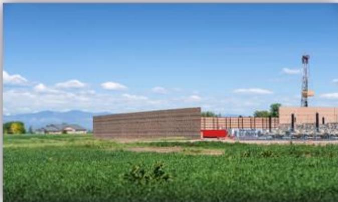
Además de las paredes acústicas, utilizamos plataformas de perforación mejoradas con características de reducción de ruido y camiones bomba de fracturación hidráulica de bajo ruido, diseñados para ser más silenciosos mediante el uso de tecnologías que reducen los niveles de ruido sin sacrificar el rendimiento operativo.
