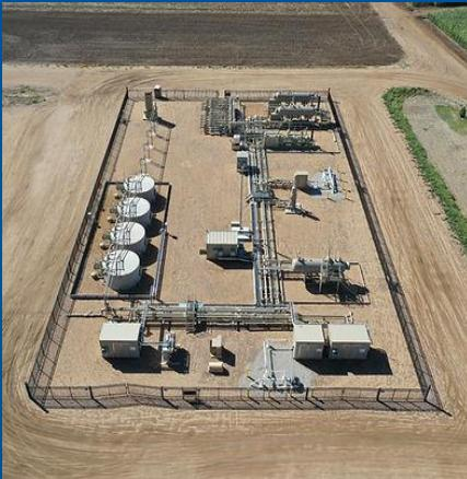
Las instalaciones de producción se construyen junto a los pozos para capturar y separar el petróleo, el gas natural y el agua que se producen. La producción de estas instalaciones requiere de 30 a 45 días de trabajo que se completan en etapas de aproximadamente cuatro meses.
