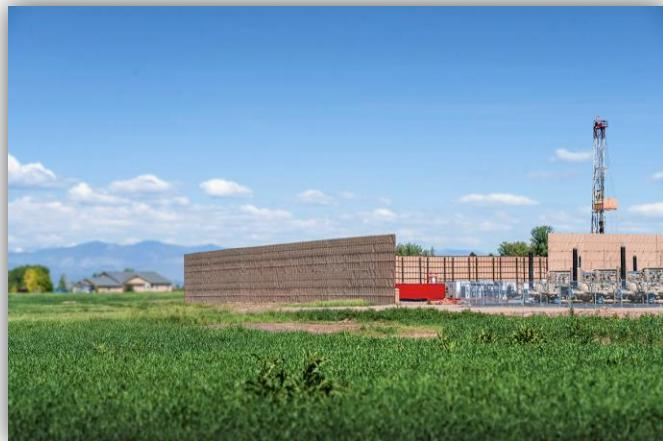
Además de las pantallas acústicas parciales, utilizamos plataformas de perforación mejoradas con características de reducción de ruido y camiones bomba de fracturación hidráulica de bajo nivel de ruido, diseñados para ser más silenciosos mediante el uso de tecnologías que reducen los niveles de ruido sin sacrificar el rendimiento operativo.
