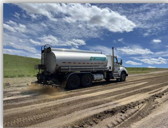
Aplicamos medidas de control de polvo en las carreteras según sea necesario. Entre las diversas técnicas utilizadas se incluyen la instalación de alfombras antipolvo y trampas de sedimentos, la hidromanta y/o la hidrosiembra en las pilas de tierra vegetal, la siembra en suelos alterados y la colocación y compactación de una capa de grava en las superficies de las plataformas de trabajo y las vías de acceso.
